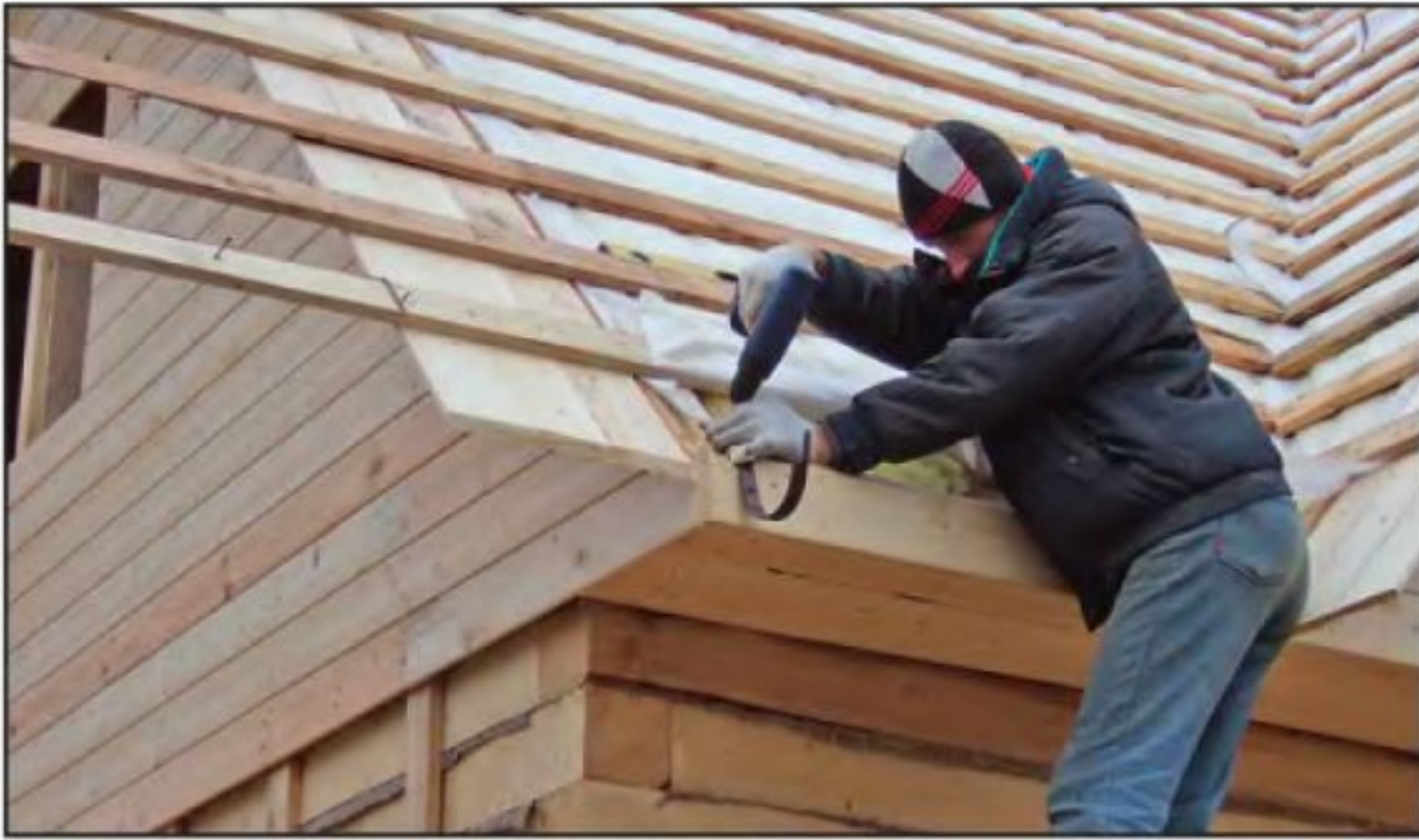
Держатели водосточных желобов крепят тоже до укладки кровли, однако при этом учитывают, где будет нижний край последней.
