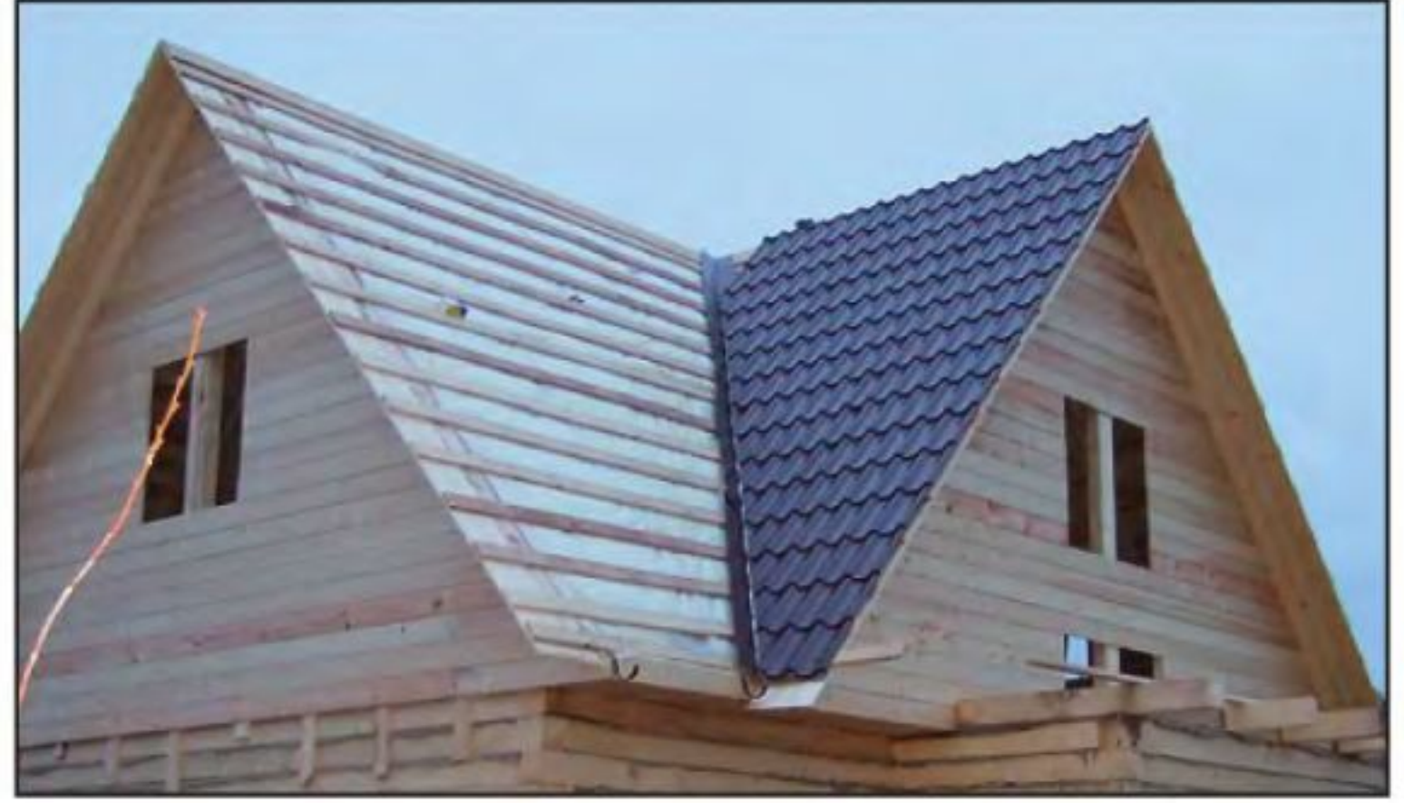
Особое внимание уделяют укладке гидроизоляции и монтажу элементов кровли вблизи ендовы.
